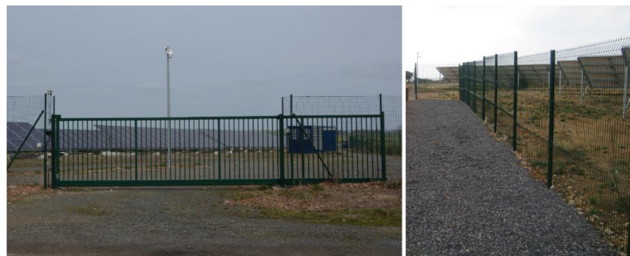
Clôture de sécurité et portail d'accès
